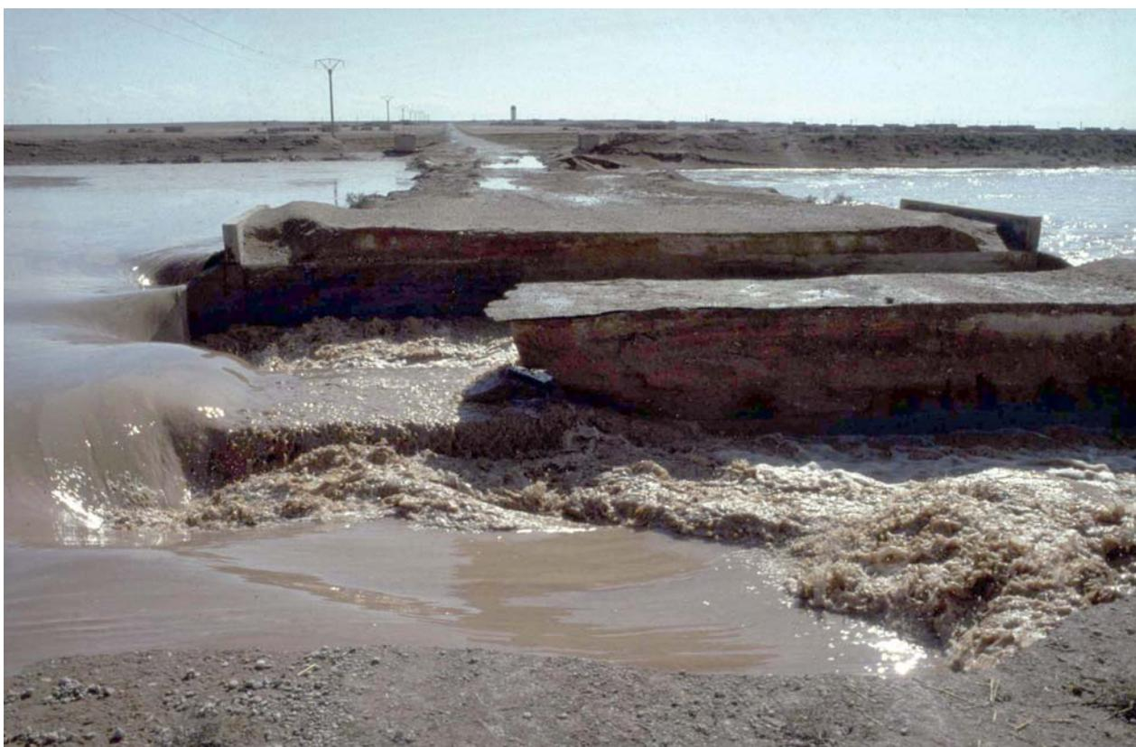
Abb. 13:10b Die Brücke und die Strasse im Dorf Gharibe kurz nach dem Wasserdurchbruch (Photo: H. Kühne 1987)
